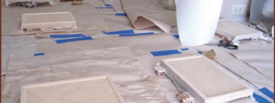
圖14 上過石灰漿·晾乾中的板子
